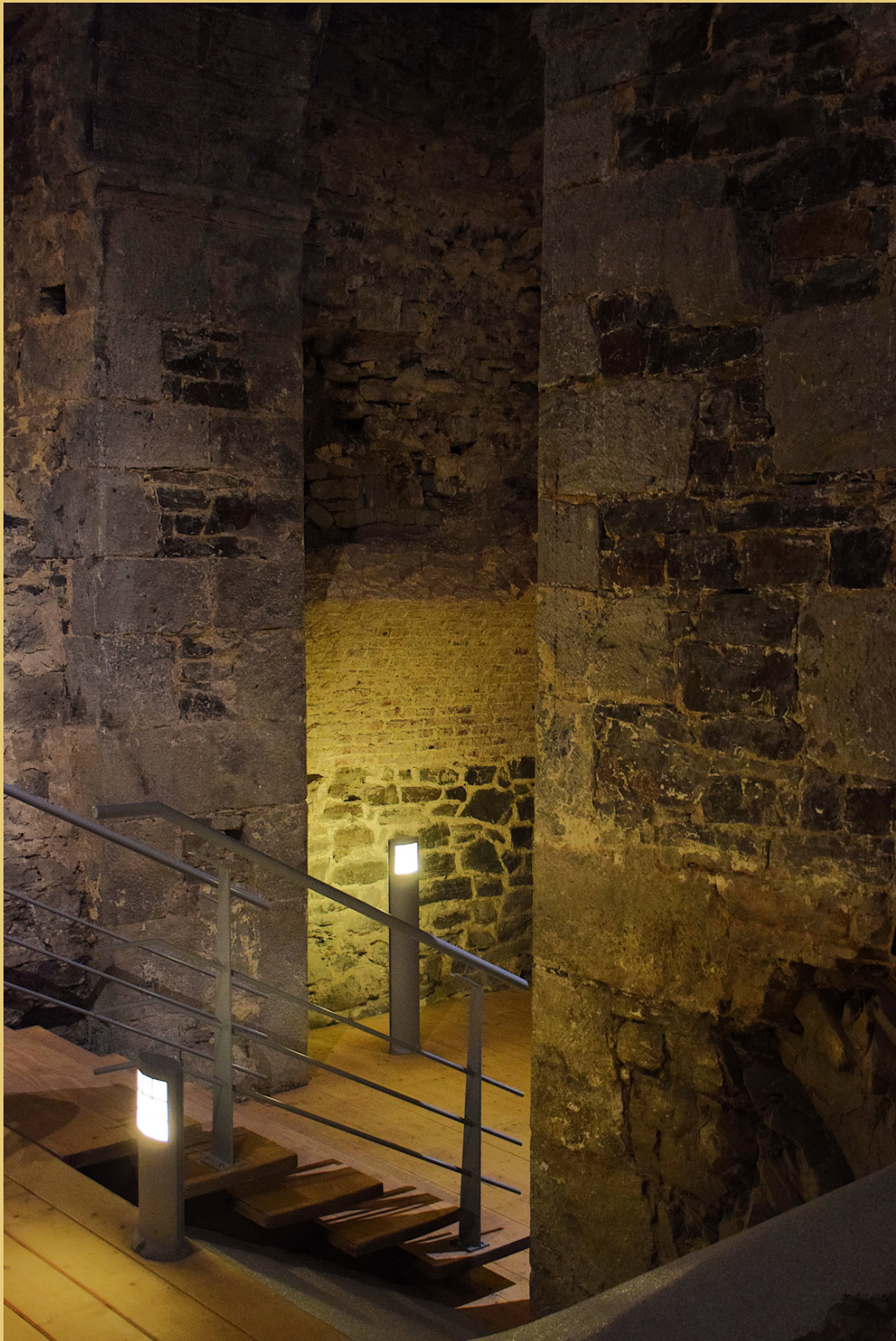
Entrée du château au 13e s (datée par la technique de la taille des pierres)
